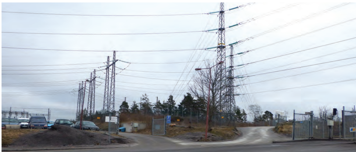
Figur 6.1. Utblick från sydväst mot befintlig kraftledning (vinkel- och julgransstolpe) och aktuellt ledningsförslag.
